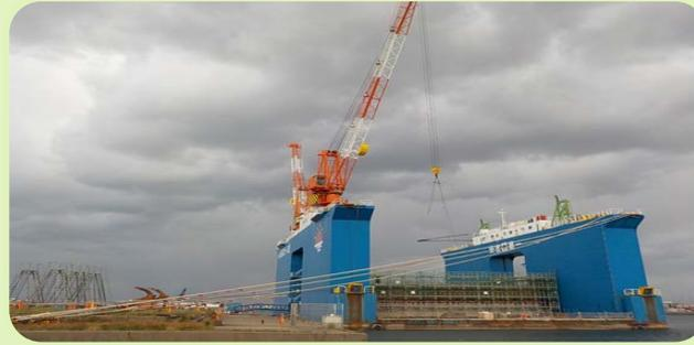
FDのクレーンで3層目鉄筋吊込
